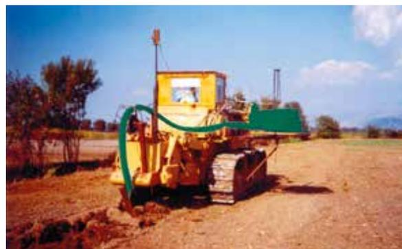
Precedentemente alla nascita di DRENOFILTER, la posa di tubo drenante con la presenza di geotessile filtrante in fibra sintetica poteva avvenire solo manualmente ed operando sulla tubazione dapprima rivestendola e poi collocandola nella trincea di destinazione.
